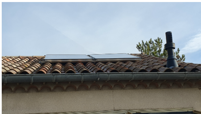
Capteurs solaires 200 SL De Dietrich
