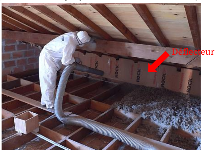
Figure 18 : mise en place d'un déflecteur en bas de toiture (© Conseils Thermiques)
