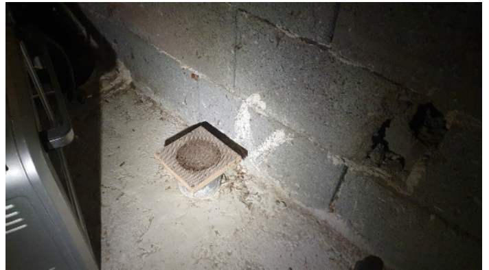
Arrivée de la bouche d'extraction des toilettes dans les combles
