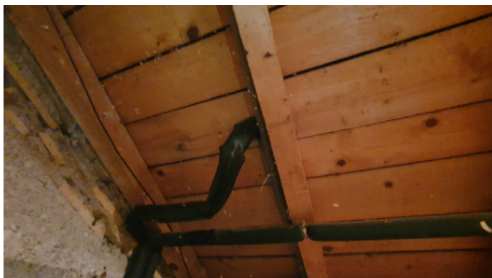
Calorifugeage léger des réseaux du chauffe-eau solaire
