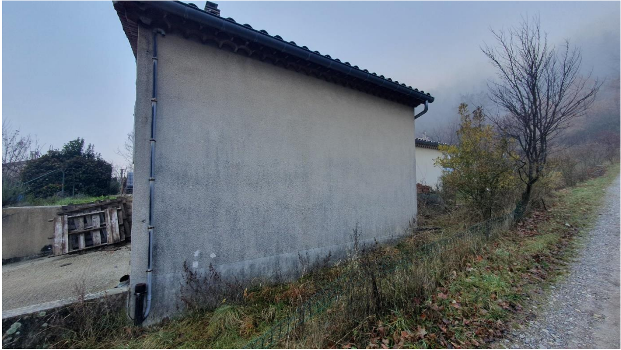
Figure 6 : traînées noires sur la façade est du garage
