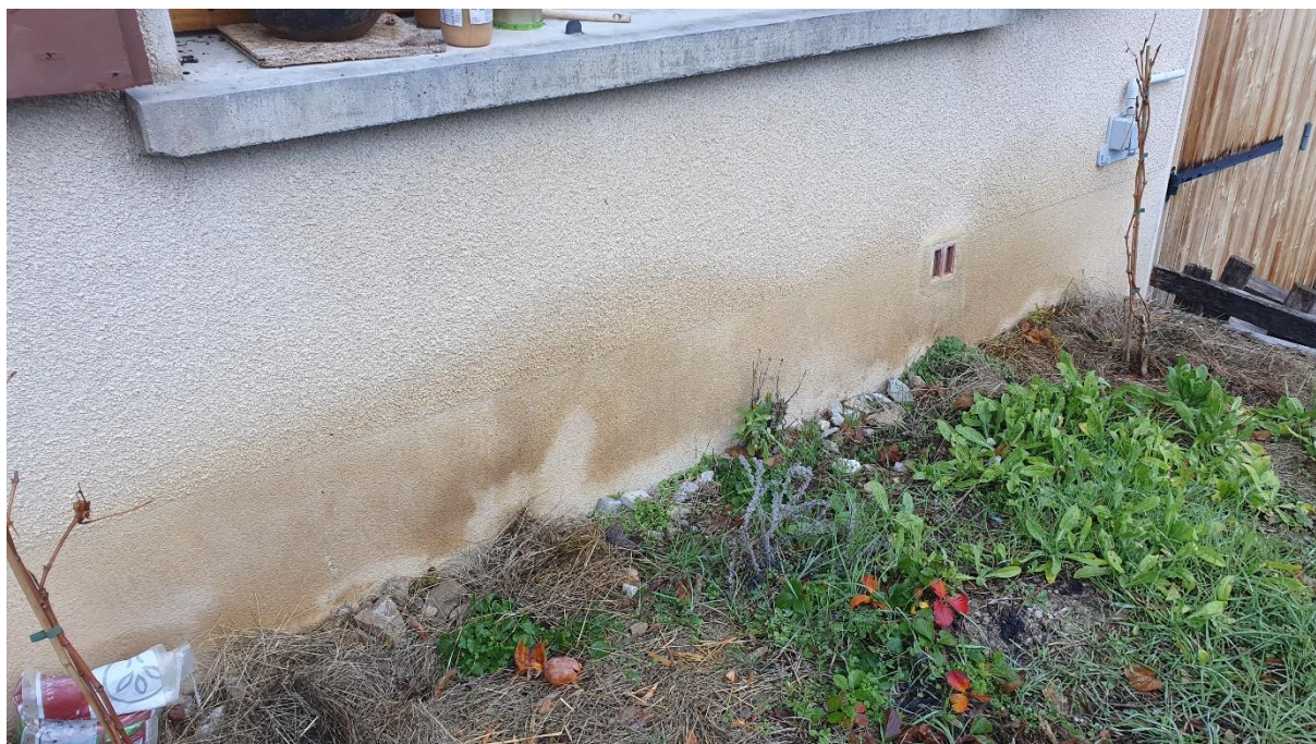
Figure 4 : auréoles en bas de mur sud
