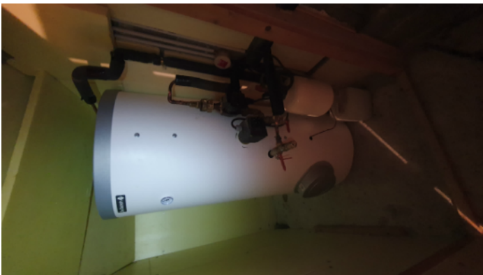
Chauffe-eau solaire De Dietrich BESL 200 N
